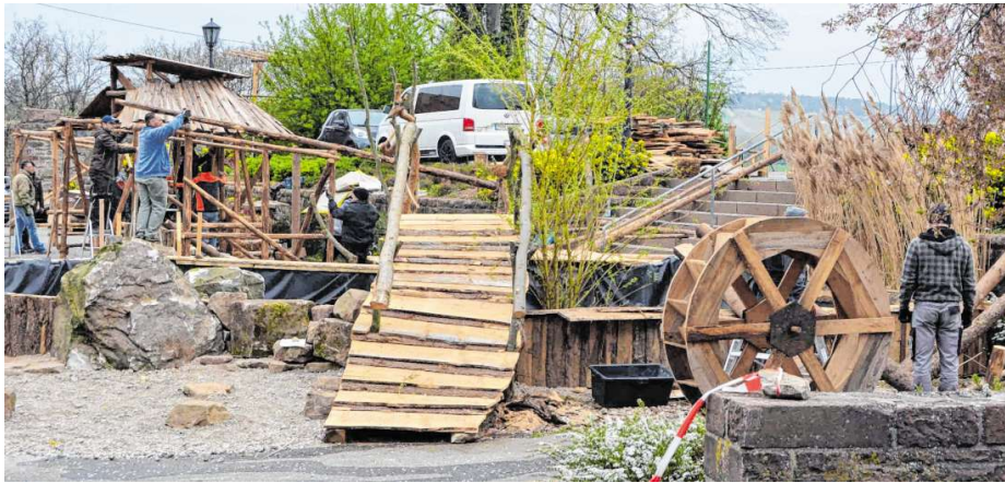
Mit großer Liebe zum Detail verwandeln die Mitwirkenden der „Burgkurzweyl zu Culleshym“ das Gelände rund um das Kilsheimer Schloss in einen mittelalterlichen Markt. Dabei wurde eine „wunderschön krumme Eiche“ zur „Unkenbrücke“ verarbeitet, die über den neuen „Schwarzen Unkenteich“ führt.
